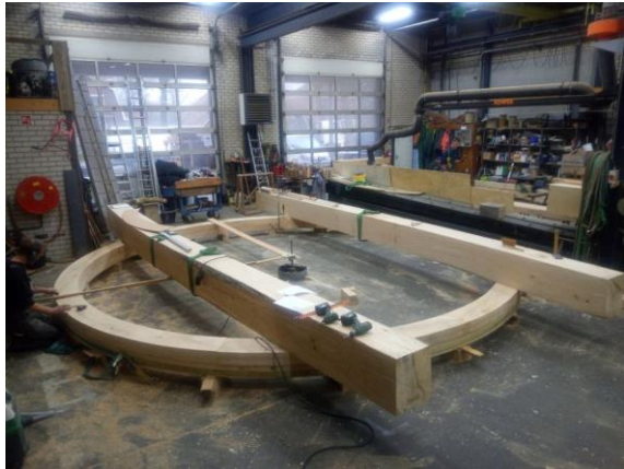
Die beiden Fugbalken liegen auf der oberen Rollenbahn.
