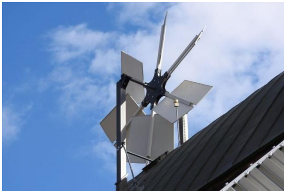
Die Windrose der Paltrockmühle
