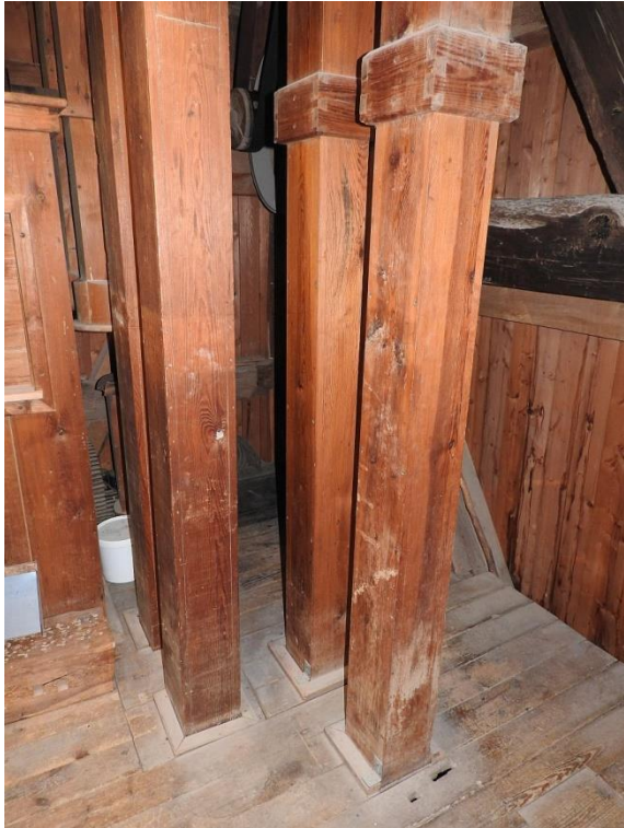
Schächte für die Becherwerke zum Transport des Mahlguts
