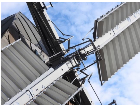
Mechanik der Klappenverstellung mit Zugstange, Spinne und Winkelhebern. Sowohl Vor- als auch Hauptheck sind bei diesen Flügeln mit Klappen versehen.
